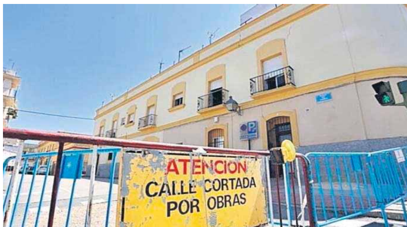
Imagen de la plaza del Carbón, cortada por los hundimientos en la calzada.
